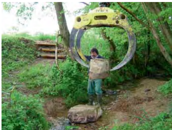
Schweres Gerät hilft beim Setzen der Furtsteine
